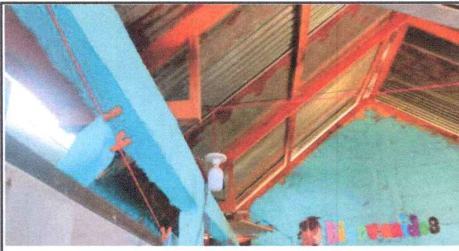
Foto 3: Bombilla dentro del salón de prepa 3. Requiere cambio por una de más potencia.
