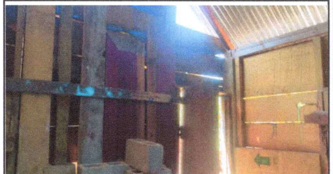
Foto 2: Parte interna donde se observa la puerta en las condiciones.
