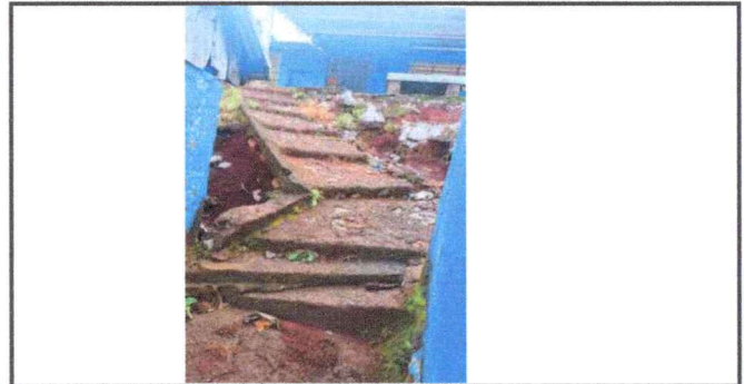
Foto 6: Las gradas que actualmente se utilizan, no presentan las condiciones adecuadas, ya que no cuentan con los pedales que normalmente se utilizan.
